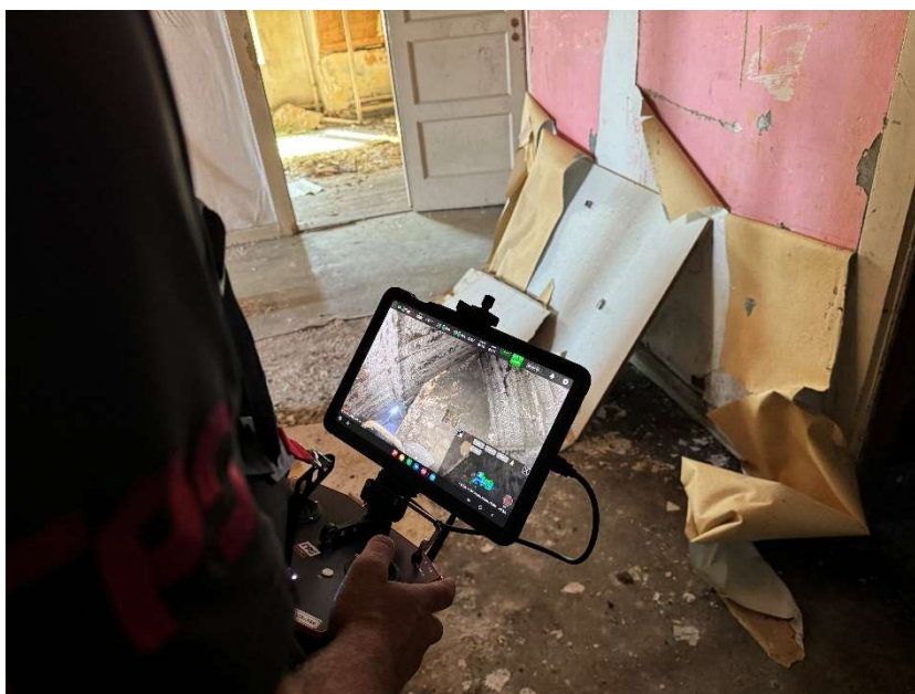
Weergave drone-camera op bedieningsscherm (het beeld laat een deels verkoalde dakconstructie zien)
