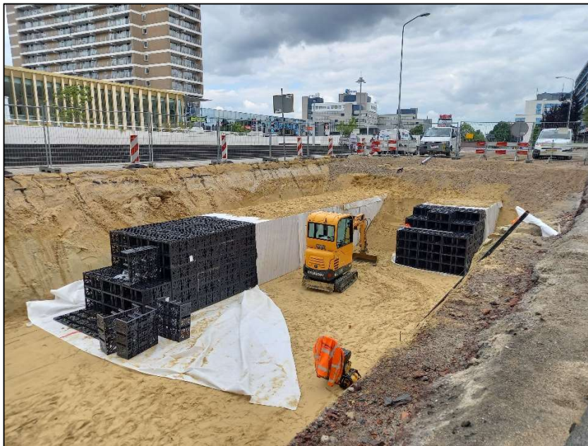
Aanleg waterbergende voorzieningen, Promenade
