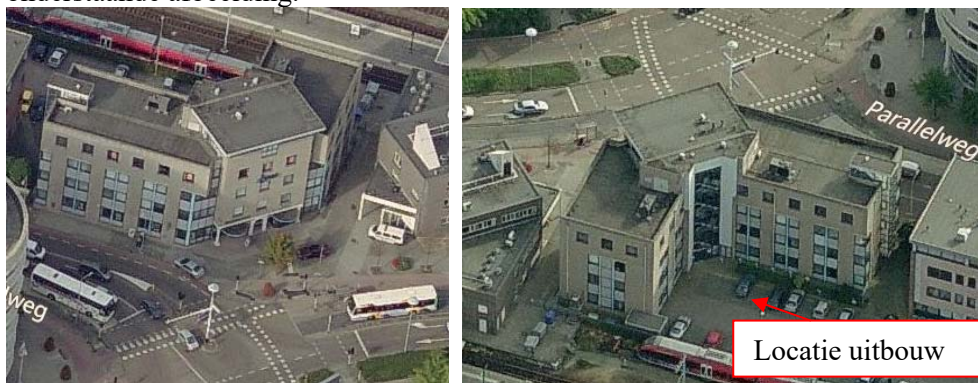
Figuur 1: Links de voorzijde en rechts de achterzijde(spoorzijde) van het pand
