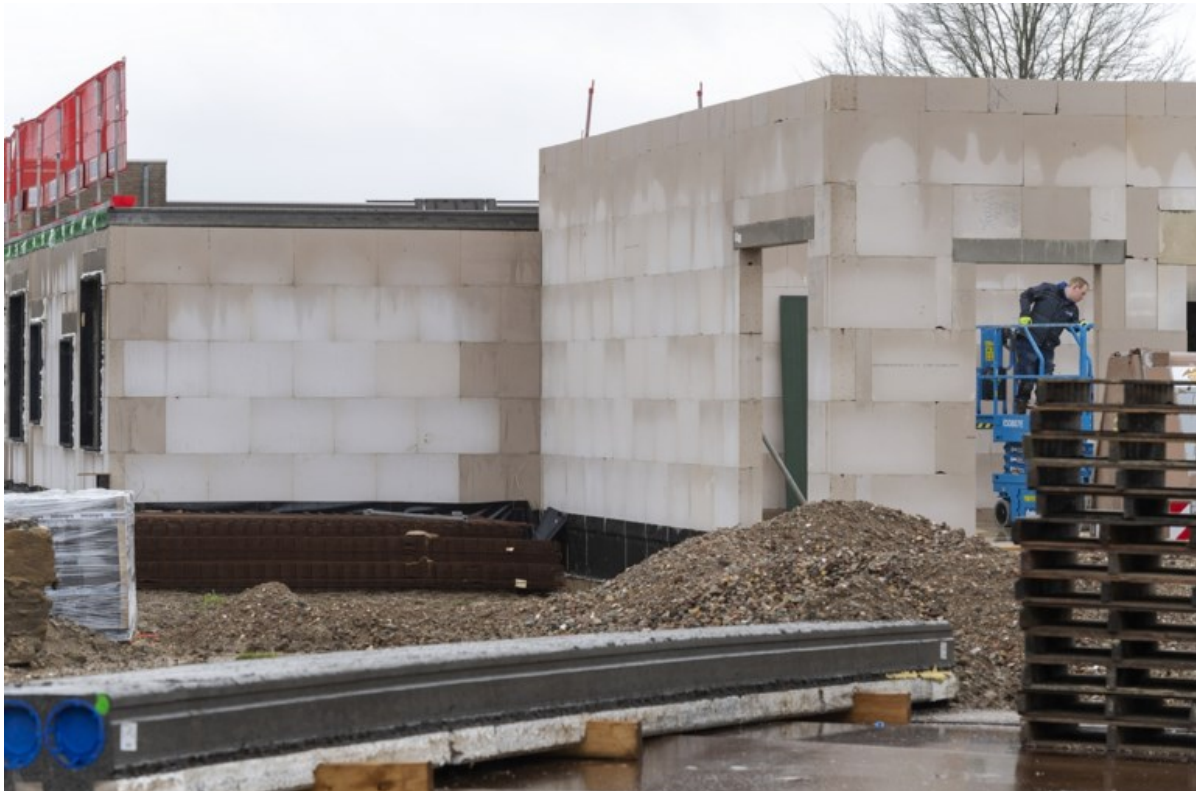
De bouw van een nieuw kindcentrum met buurthuis voor Passart is in volle gang. Foto: Peter Schols
