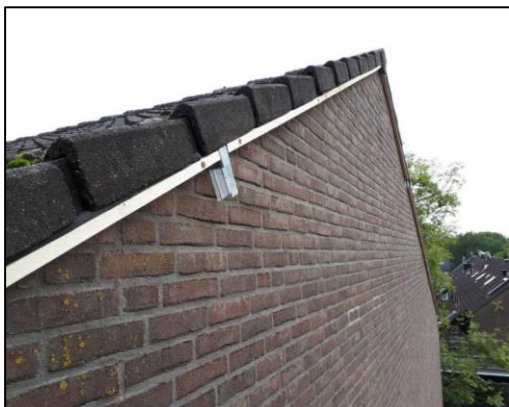
Figuur 4-3. Spleetvormige ruimte onder kantpannen afgedicht met latten en exclusion flaps.
