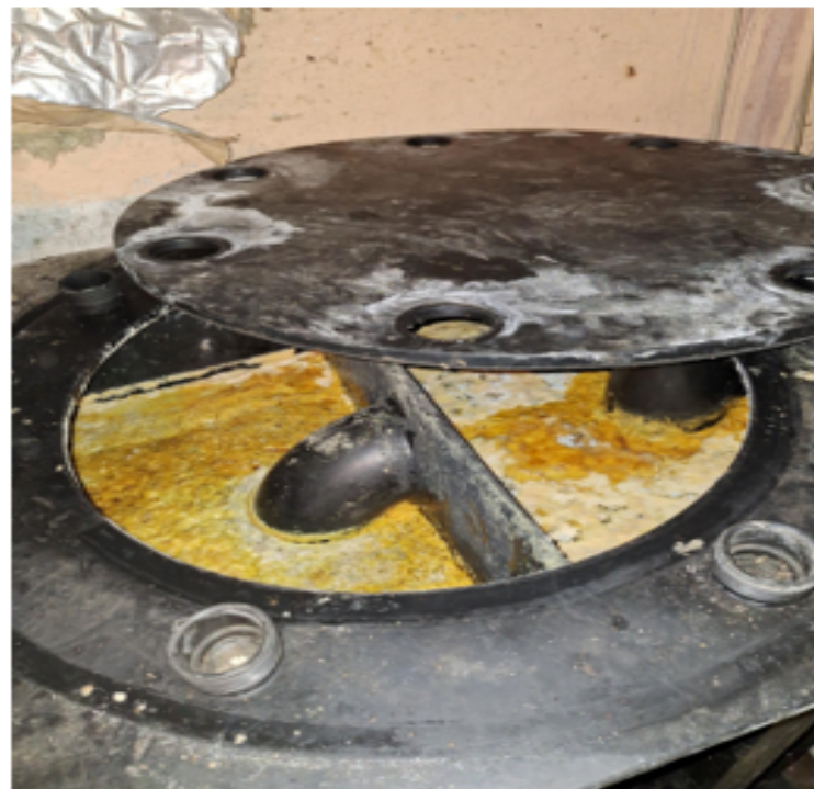
Niet tijdig geledigde vetafscheider
